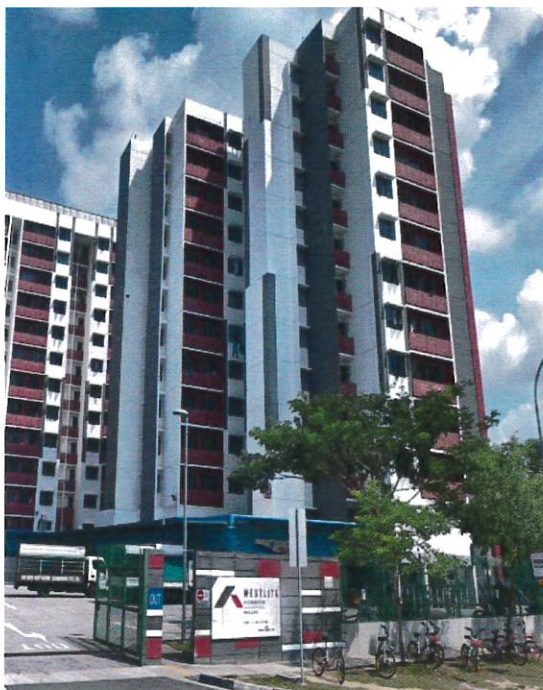
Foto 2 : Pembangunan CLQ Weslite Woodlands , Singapura
