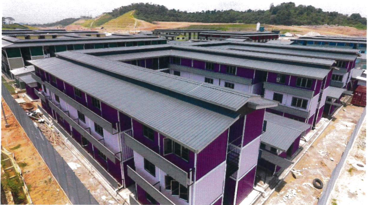
Foto 4 : Contoh Pembangunan CLQ MRT Sg. Buloh, Selangor
